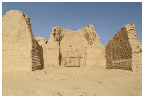
8. 白杨沟佛寺大佛殿(东南-西北)
